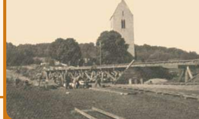
Travaux de chemin de fer à l'automne 1915
